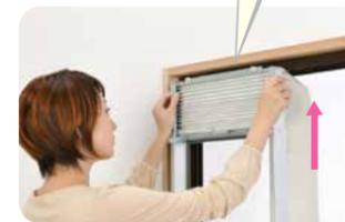
枠上部を上へ押し付けながら中央2本のネジを締めます。
