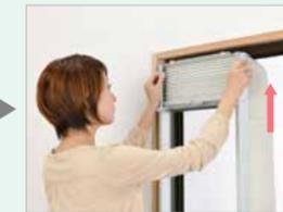
手回しネジで窓枠を固定する。
