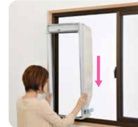
柱側いっぱい寄せて下側のネジを締め付けます。
