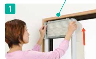
枠上部を上へ押し付けながら中央2本のネジを締めます。
