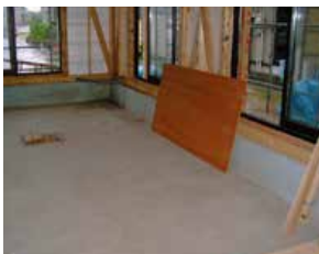
〈基礎断熱工法による土間〉
