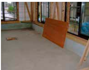
〈基礎断熱工法による土間〉
