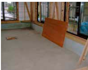
〈基礎断熱工法による土間〉
