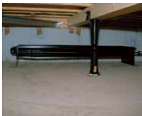
〈放熱器の取り付け〉
