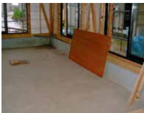
〈基礎断熱工法による土間〉
