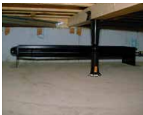
〈放熱器の取り付け〉
