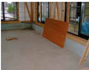
〈基礎断熱工法による土間〉
