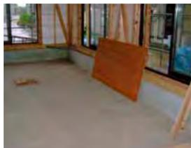
〈基礎断熱工法による土間〉
