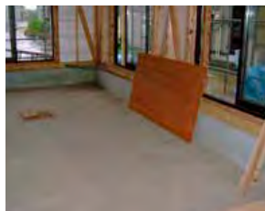
〈基礎断熱工法による土間〉
