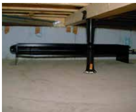
〈放熱器の取り付け〉
