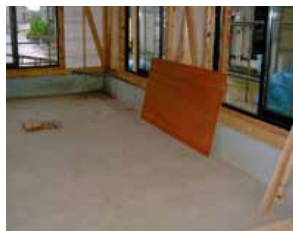
〈基礎断熱工法による土間〉
