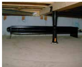
〈放熱器の取り付け〉
