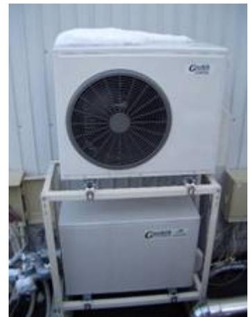
設置事例(上: 空気熱ヒートポンプ、下: 地中熱ヒートポンプ。写真は試験機具のため色相が異なります)
